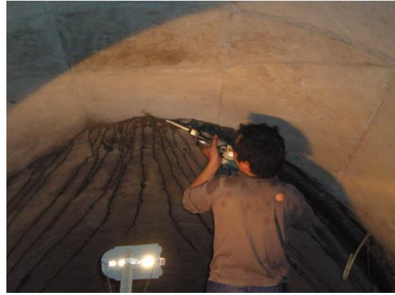
1010 廊道内外漏封堵
