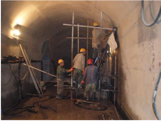
1060 廊道上仰孔钻设
