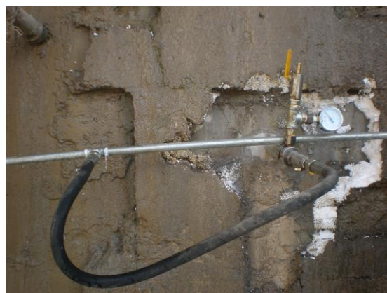
孔口管与灌浆管路安装
