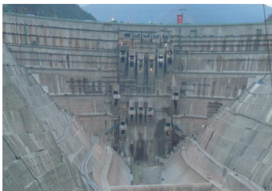
小湾电站坝后全景照
