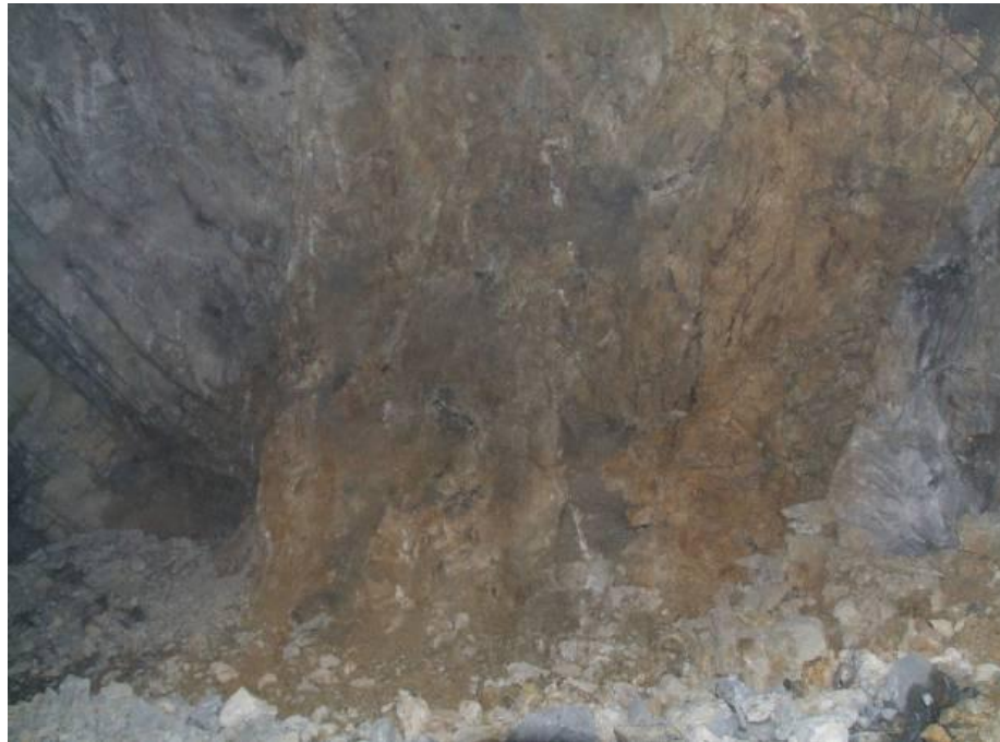
f5 断层（K0+054~K0+064）部位破碎带（粗砂）
