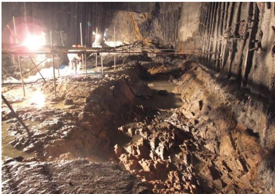
f5 断层（K0+078~K0+088）部位夹泥层（黄泥）
